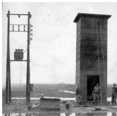
Premier poste électrique.
