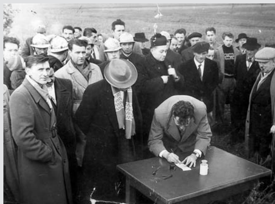
Pose de la première pierre.
