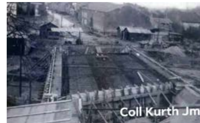
Ferrailage du nouveau pont 17 novembre 1941
