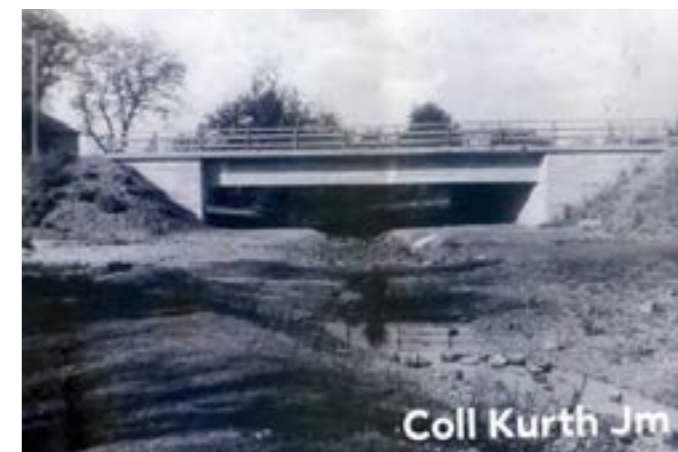
Pont terminé fin octobre 1942.
