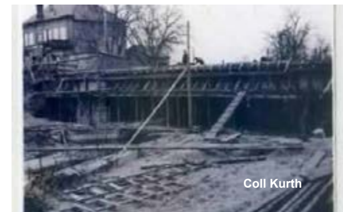
Coffrage, ferrailage, du nouveau pont, derrière l'école de garçons 14 novembre 1941
