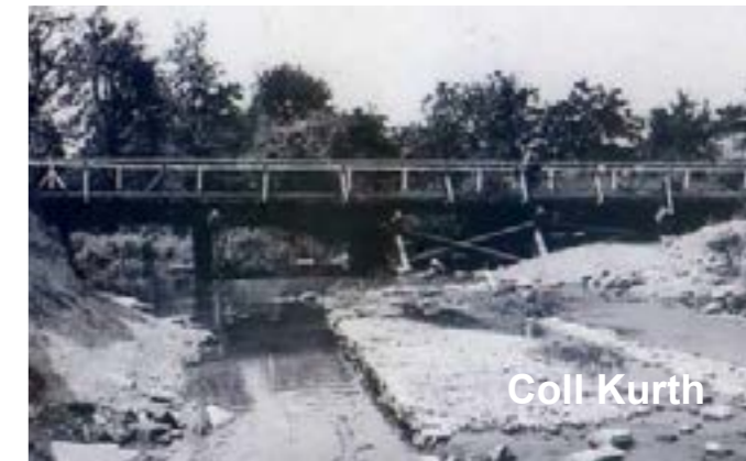
Pont provisoire en bois installé en 4 jours, juillet 1940
